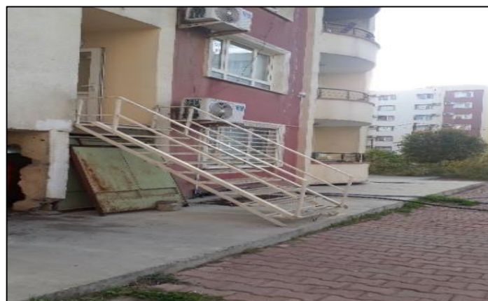
شكل (أ) عدم ملائمة السلم الخارجي المؤدي
